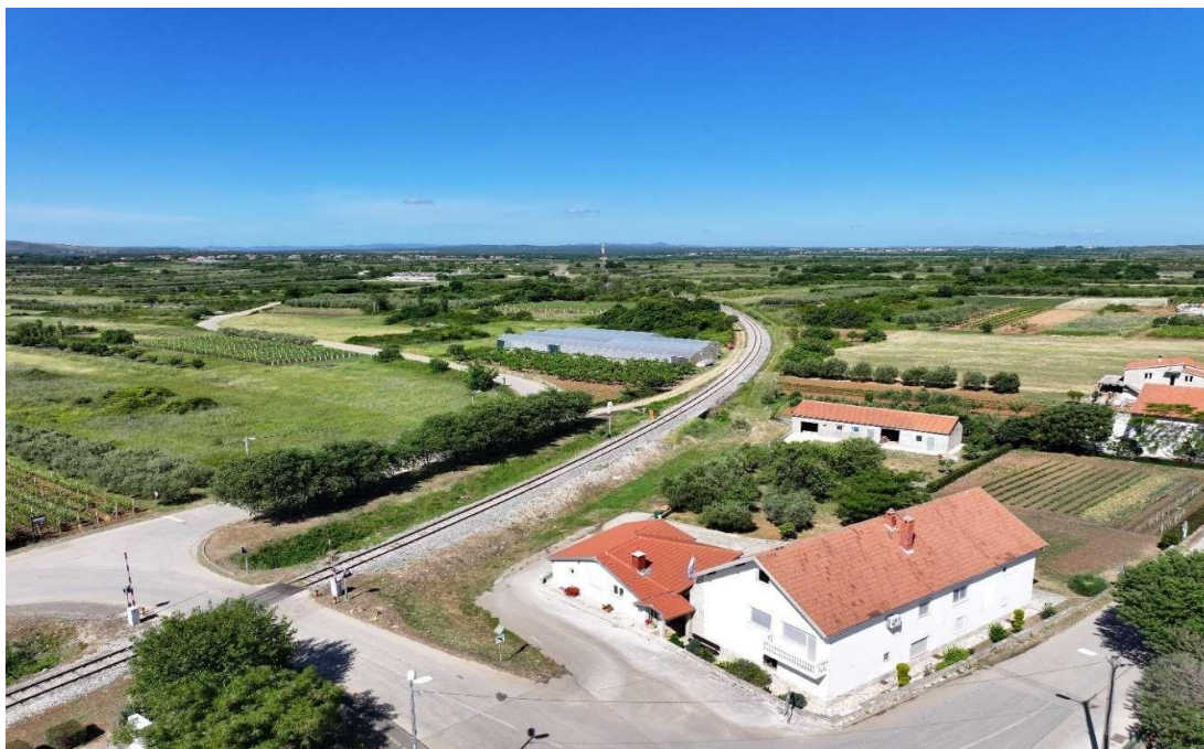
Slika C5. Pogled na križanje županijskih cesta Ž C021 i Ž C044 te željezničku prugu Knin - Zadar, izvor : Level Project d.o.o.
