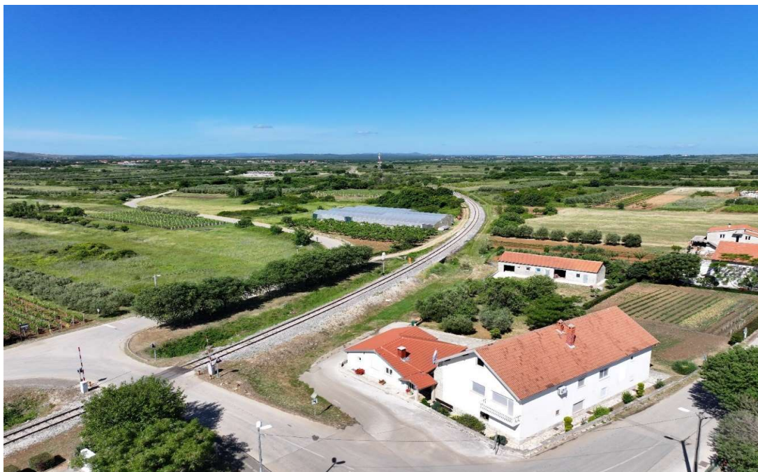
Slika 65. Pogled na križanje županijskih cesta Ž 6021 i Ž 6044 te željezničku prugu Knin – Zadar, izvor : Level Project d.o.o.
